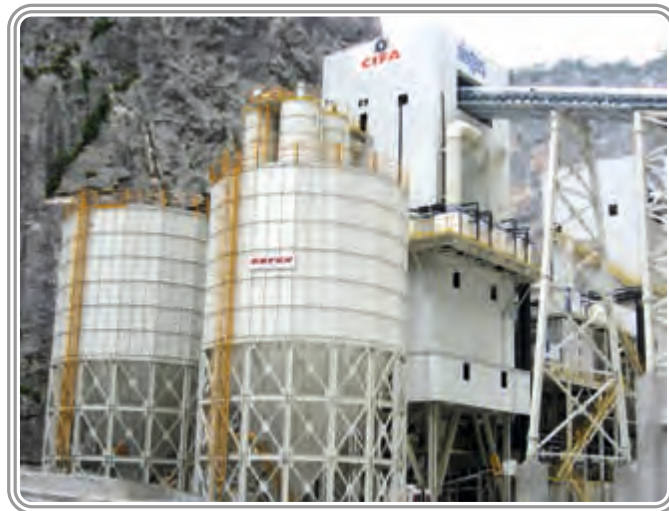
Boyobat Barajı DOĐUŐ İnőaat 1200 ton Kapasiteli Dört Adet Harici Çimento Siloları Toplam Kapasite 4800 ton
