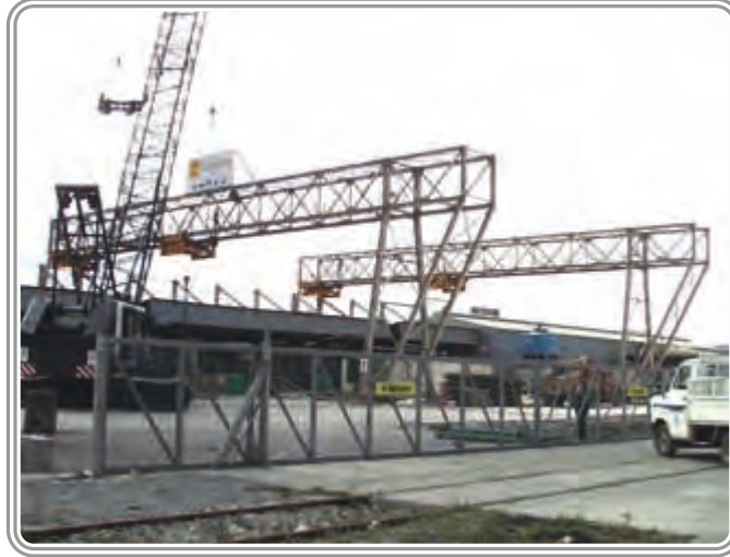
EUPEC PIPE COATINGS GmbH. (ALMANYA) SAMSUN MAVİ AKIM DOĐALGAZ ŐANTİYESİ ŐELİK KONSTRÜKSİYON YAPILAR + VİNŐLER + KONVEYÖRLER
