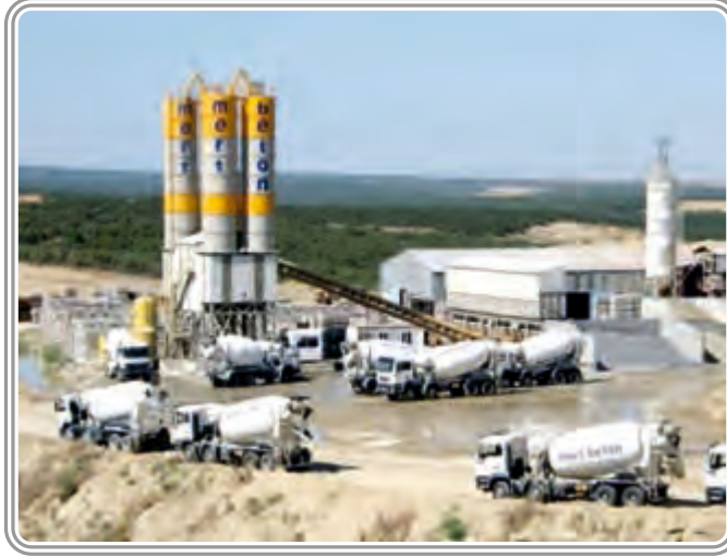
Mert Beton Türkiye İstanbul / Silivri 90 m 3 /saat Yaş Karışım Beton Santrali
