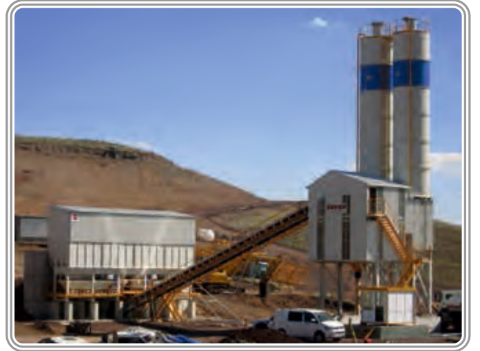
DOĞUŞ İnşaat / Kırkkale tesisi 90 m 3 /saat Yaş Beton Santrali
