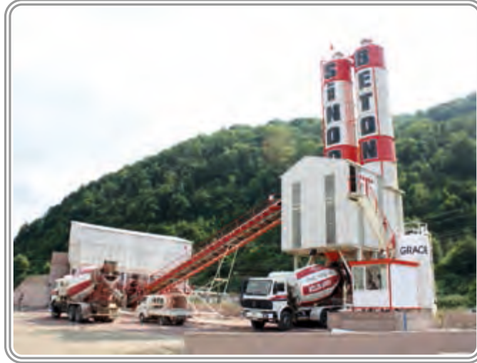
Sinop Beton 90 m 3 /saat Yaő Karıőım Hazır Beton Santrali
