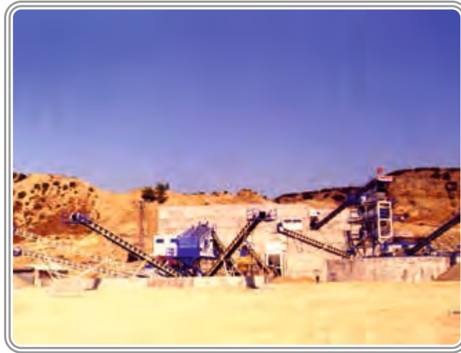
KİTAŞ İNŞ. TİC. VE MADENCİLİK A.Ş.Çerkezköy / İSTANBUL 200 Ton/saat STABİLİZE DAĞ KUMU YIKAMA - ELEME - AYIRMA TESİSİ
