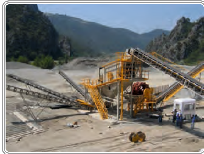
DOĐUŐ İNŐAAT VE TİCARET A.Ő. (Boyabat Barajı)DuraĐan / SİNOP 200 Ton/saat DERE MALZ. YIKAMA- ELEME TESİSİ
