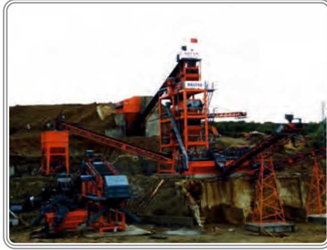
HASTAŞ KUM OCAKLARI SANAYİİ LTD. ŞTİ. İSTANBUL 200 Ton/saat STABİLİZE DAĞ KUMU YIKAMA - ELEME - AYIRMA TESİSİ
