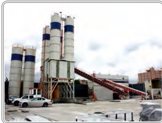
Nimsan / Akçansa / Samsun 120 m 3 /saat Yaő Karıőım Hazır Beton Santrali
