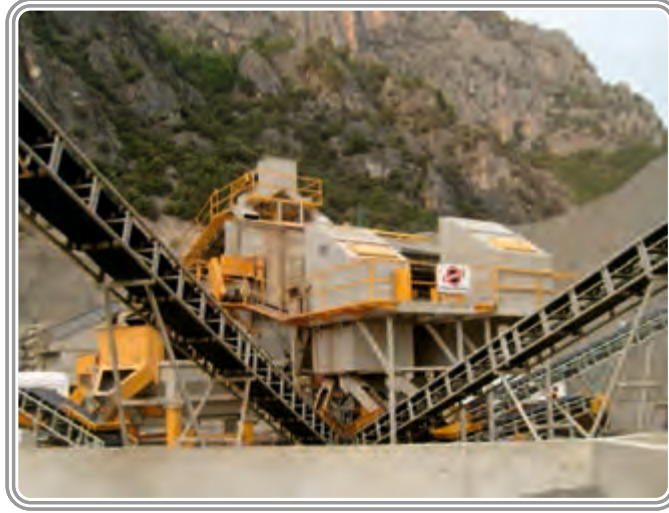
DOĞUŞ İNŞAAT VE TİCARET A.Ş. İSTANBUL 200 Ton/saat KUM - ÇAKIL YIKAMA ELEME TESİSİ
