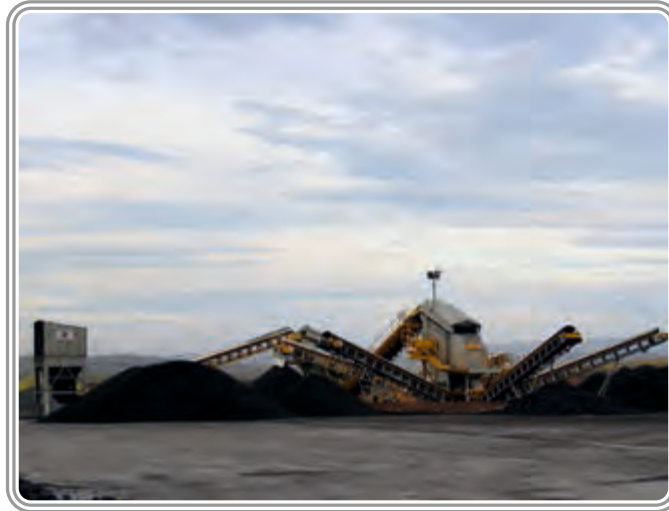
AEE MADENCİLİK İNŞ. VE DIŞ TİC. A.Ş.Marmara Ereğlisi / TEKİRDAĞ 200-220 Ton/saat KÖMÜR ELEME TESİSİ
