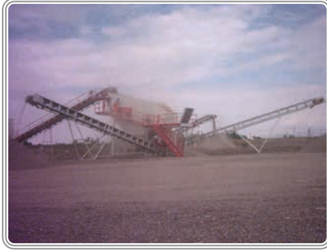
AGT "AZVİRT" 200 ton/saat Taő Kırma Eleme Tesisi. AZARBEYCAN
