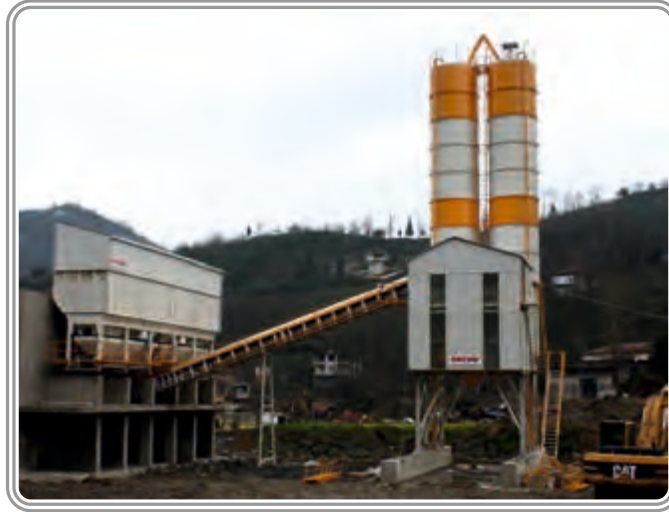
Yama-Ko İnŐaat Malz. Paz. San. Ltd. Őti. Rize / Kalkandere Tũrkiye 90 m 3 /saat YaŐ KarıŐım Beton Santrali
