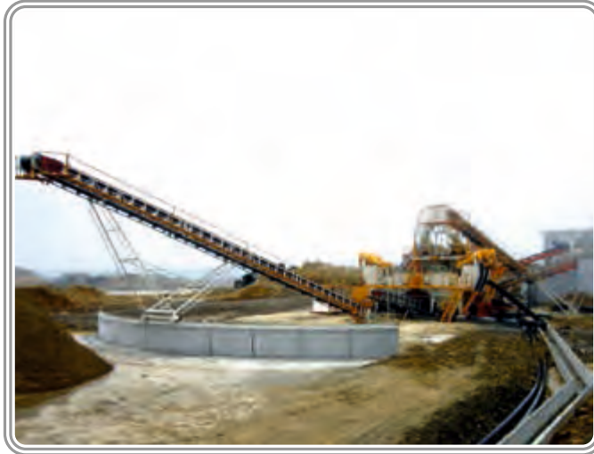
REHA AMBALAJ SAN. & KUZEY İSTANBUL - GÖKTÜRK / İSTANBUL 400 ton/saat KUM YIKAMA, DAĞ MALZEMESİ KIRMA ve ELEME TESİŐİ
