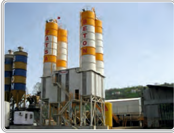
Fatsa Beton Ordu / Fatsa Türkiye 120-130 m 3 /saat Yaő Karıőım Beton Santrali
