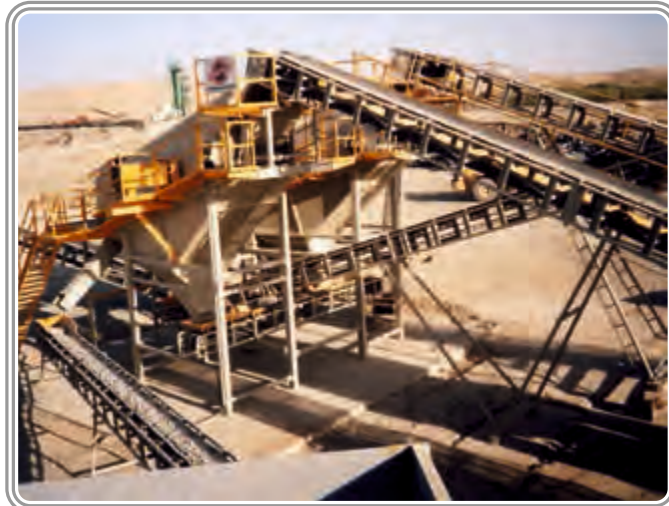
GÜLSAN – ÇUKUROVA ORTAK GİRİŞİMİ Kandahar / AFGANİSTAN 300 ton/saat DERE MALZEMESİ KIRMA ve ELEME TES. 2 ÜNİTE
