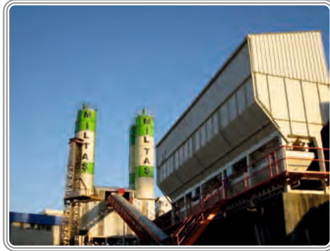
MiltaŐ Beton İstanbul / AğaoĐlu İnŐaat - My World Europe (Ayazma) Türkiye 120 m 3 /saat YaŐ karıŐım hazır beton santrali
