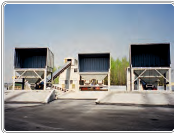
MAT MADENCİLİK İNŐAAT TEKS. SAN. TİC. LTD. ŐTİ.Gebze / KOCAELİ 20 ton/saat K m r Paketleme Tesisi.
