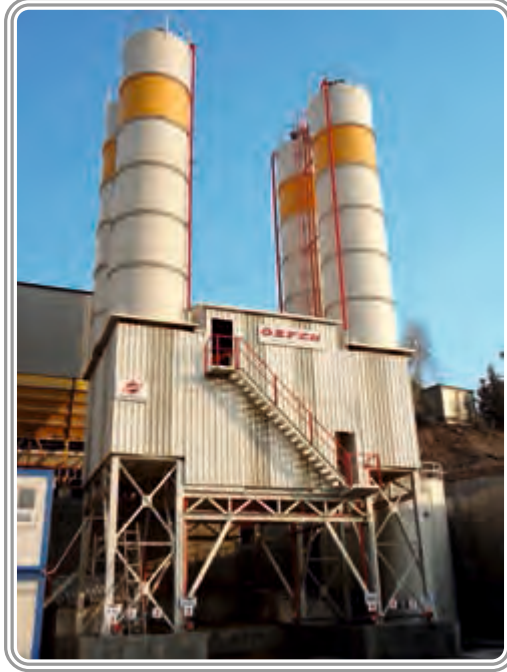
BOĐAZİÇİ Beton Kemerburgaz / İstanbul 120 m 3 /saat Yaő Karıőım Hazır Beton Santrali
