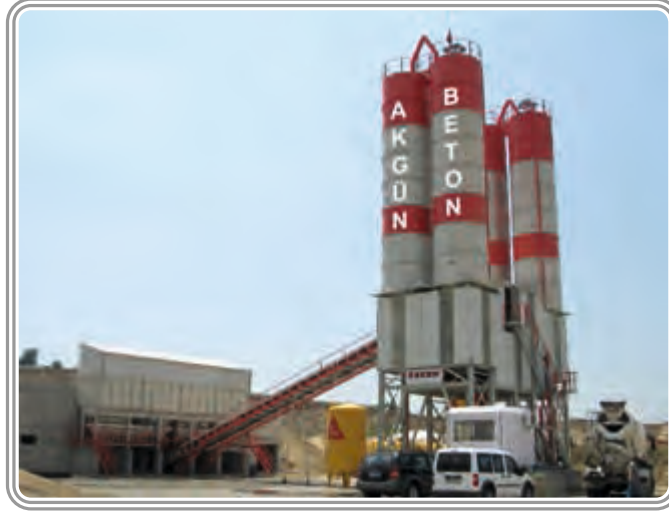
Akgün Beton Türkiye Çorlu 90 m 3 /saat Yaş Karışım Beton Santrali
