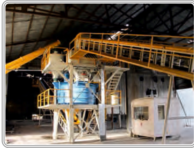
Eti Krom Maden illetmeleri "Yıldırım Holding" Türkiye 70 m 3 /saat Yaő karıřım hazır beton santrali
