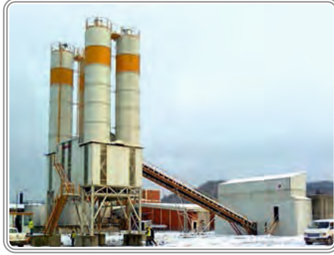
AZVİRT MMC / SİRBİSTAN 120 m 3 /saat YAŞ KARIŞIM HAZIR BETON SANTRALİ
