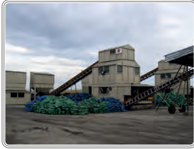
AEE MADENCİLİK İNŞ. VE DIŞ TİC. A.Ş.Marmara Ereğlisi / TEKİRDAĞ 80 ton/saat Kömür Paketleme Tesisleri.
