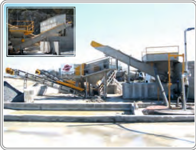
YAŞ BETON GERİ DÖNÜŞÜM TESİSLERİ
