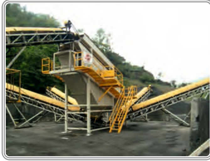
SAFİ KATI YAKIT SAN. TİC. LTD. ŞTİ.TRABZON 200-220 Ton/saat KÖMÜR ELEME TESİSİ
