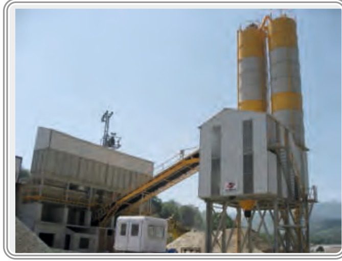
Yama-Ko İnşaat Malz. Paz. San. Ltd. Şti. Rize / İkizdere Türkiye 90 m 3 /saat'lik Yaş Karışım Hazır Beton Santrali
