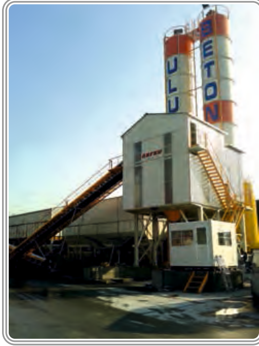
ULU Beton İstanbul / Esenyurt 120 m 3 /saat Yaş Karışım Hazır Beton Santrali
