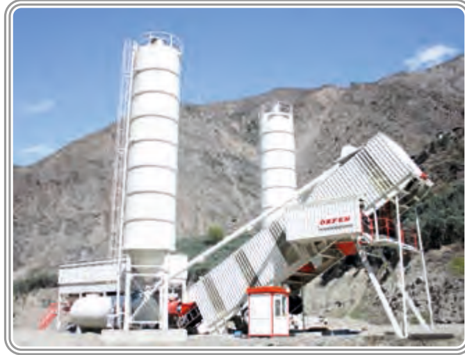
DOĞUŞ İnşaat / Artvin / Yusufeli Barajı 70 m 3 /saat Yaş Karışım Mobil Hazır Beton Santrali
