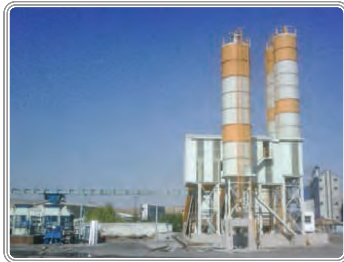
Eti Krom Maden İşletmeleri "Yıldırım Holding" Türkiye 70 m 3 /saat x 2 çift mikserli Yaş ve Kuru Karışım Hazır Beton Santrali "70 m 3 /saat x 2 mikserli, Çift Tartımlı ve Çıkışlı, Parke Taşı Ünitesi Beslemeli Hazır Beton Santrali"
