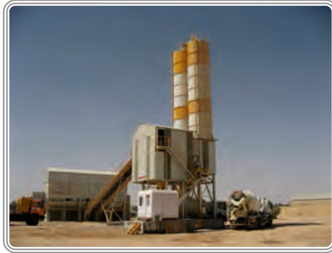
Doğuş İnşaat ve Ticaret A.Ş. Libya / Sirte Üniversite şantiyesi 90 m 3 /saat Yaş Karışım Beton Santrali
