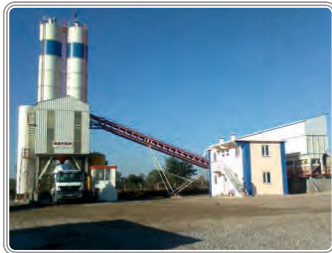
TAŞTAN Beton Edirne / Havsa 90 m 3 /saat Yaş Karışım Hazır Beton Santrali
