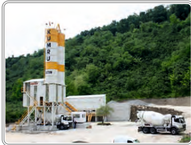
Kumru Beton Ordu / Kumru Türkiye 90 m 3 /saat'lik Yaş Karışım Hazır Beton Santrali
