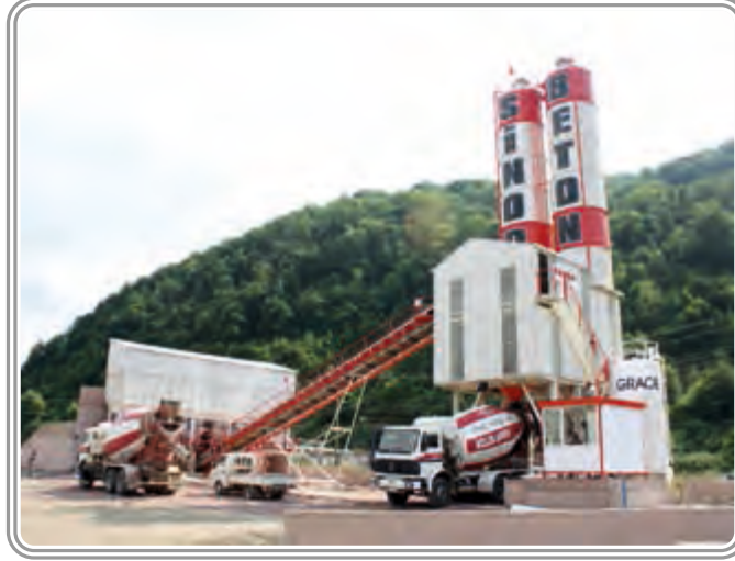
Sinop Beton 90 m 3 /saat Yaş Karışım Hazır Beton Santrali
