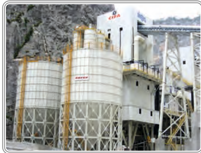
Boyobat Barajı DOĞUŞ İnşaat 1200 ton Kapasiteli Dört Adet Harici Çimento Siloları Toplam Kapasite 4800 ton
