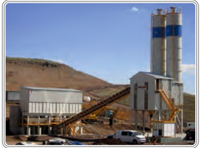
DOĞUŞ İnşaat / Kırıkkale tesisi 90 m 3 /saat Yaş Beton Santrali
