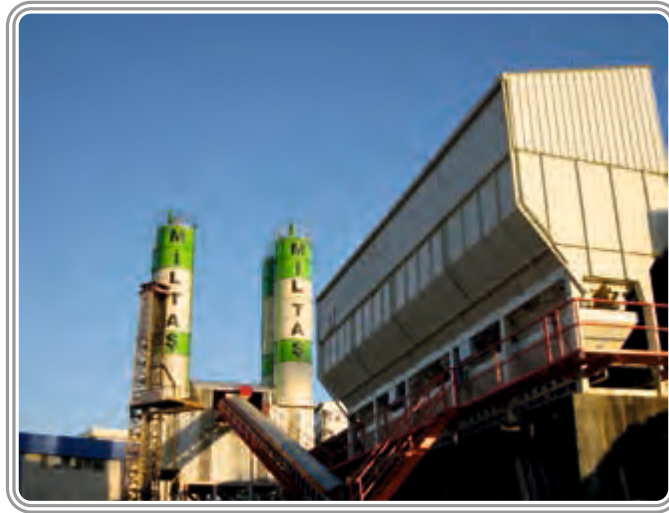
Miltaş Beton İstanbul / Ağaoğlu İnşaat - My World Europe (Ayazma) Türkiye 120 m 3 /saat Yaş karışım hazır beton santrali
