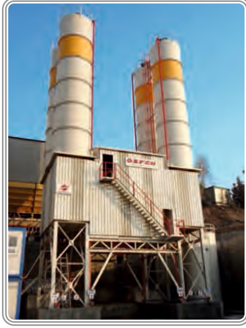
BOĞAZIÇI Beton Kemberburgaz / İstanbul 120 m 3 /saat Yaş Karışım Hazır Beton Santrali
