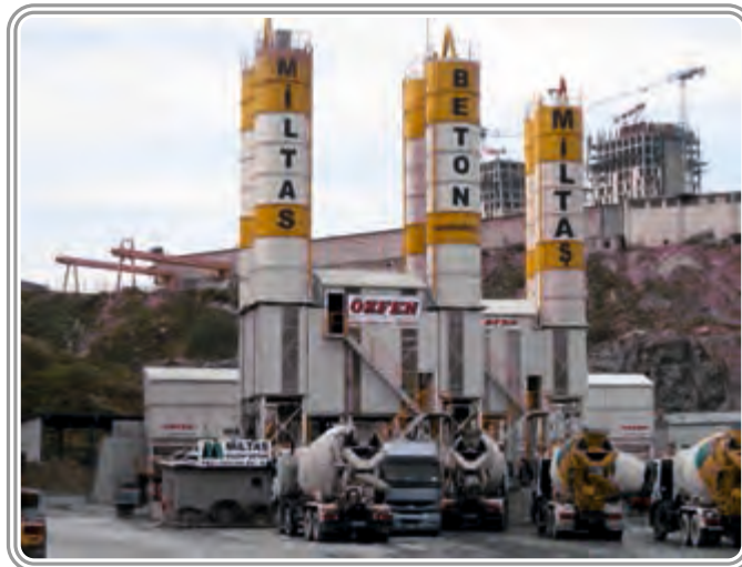
Miltaş Beton İstanbul / Kartal "Marmaray Projesi" Türkiye 90 m 3 /saat Yaş karışım hazır beton santrali
