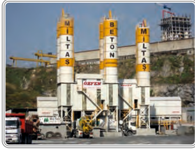
Miltaş Beton İstanbul / Kartal "Marmaray Projesi" Türkiye 120 m 3 /saat Yaş karışım hazır beton santrali
